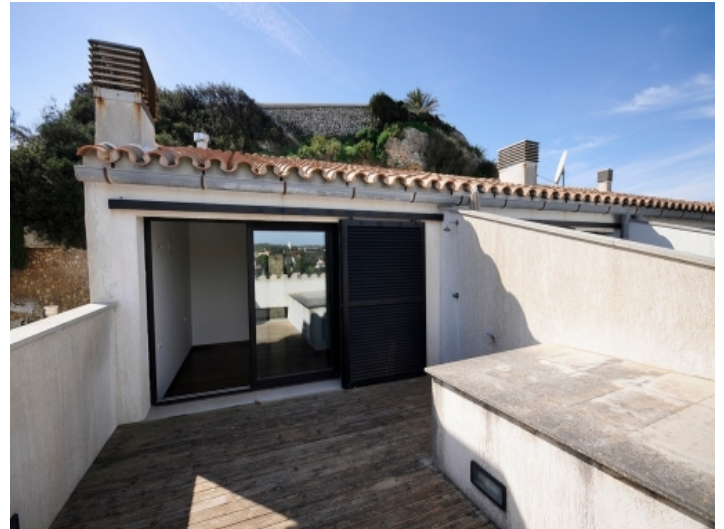
Auf der Dachterrasse befindet sich außerdem eine Dusche
