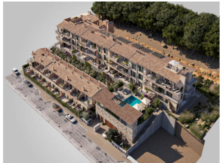
Neubau Anlage Capdepera-zentral
