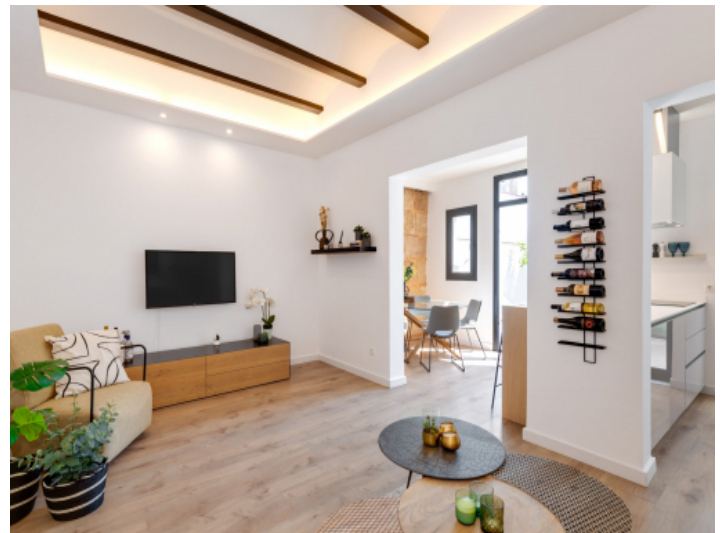
Kappendecke mit indirekter Beleuchtung
