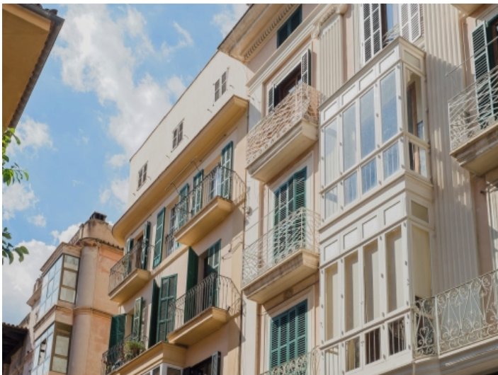
Ansicht des Gebäudes
