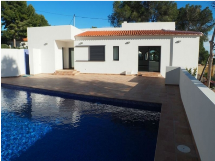
Großzügig geschnittener Poolbereich
