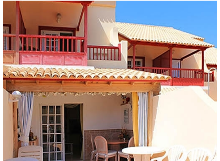
Blick auf den hinteren Teil des Hauses
