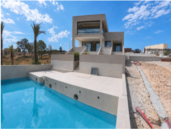
Privater Pool und moderne Villenfassade in Son Gual
