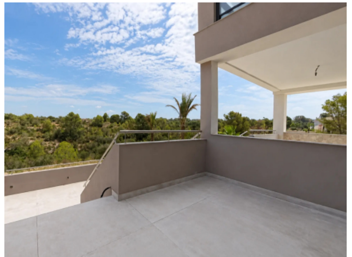
Überdachte Terrasse mit freiem Landschaftsblick
