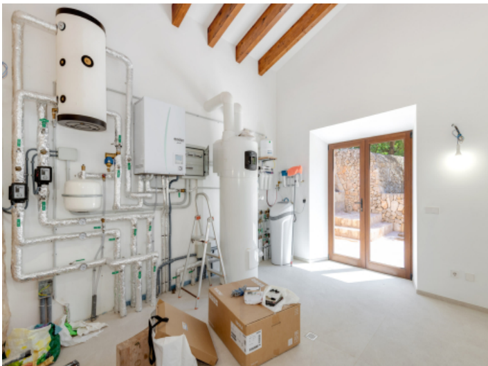
Abstell- und Technikraum
