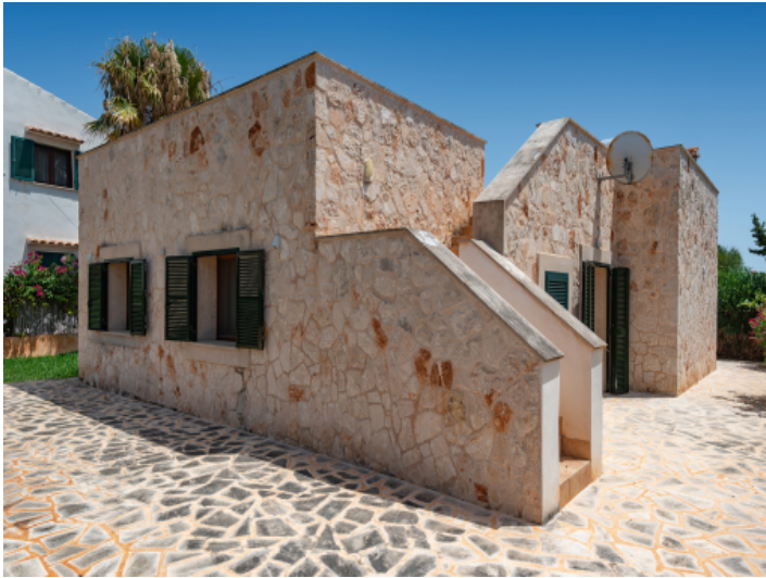
Aufgang zur Dachterrasse
