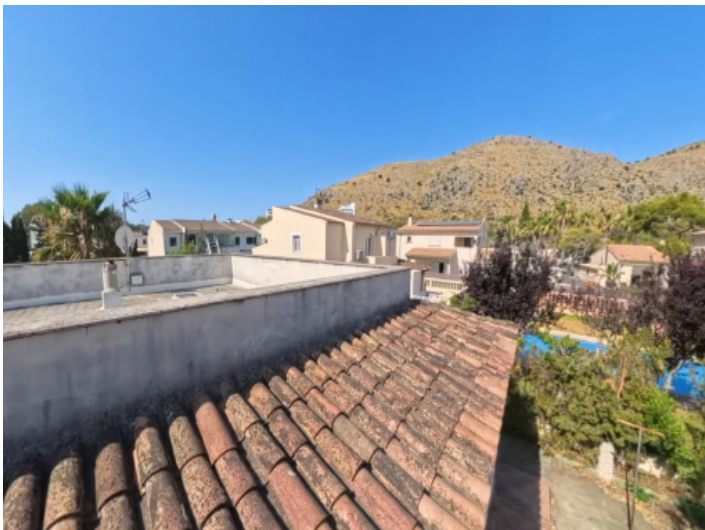
Dachblick in Richtung Berge
