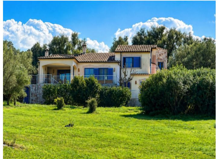
Ansicht des Hauses vom unteren Teil des Grundstücks
