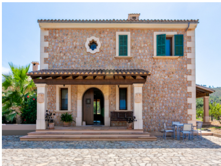
Frontansicht der Steinfınca
