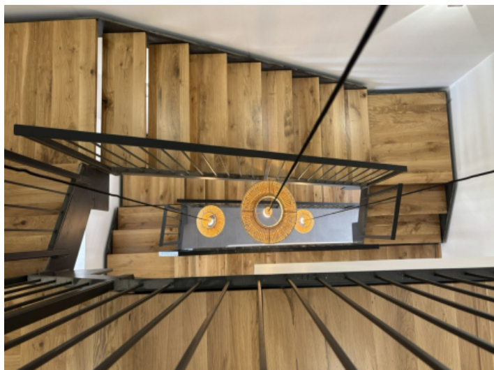
Blick auf das offene Treppenhaus mit Holz und Stahl
