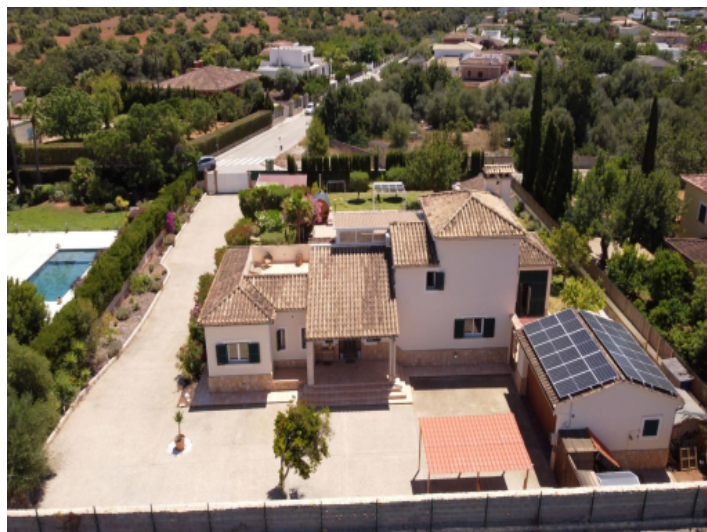
Ansicht auf die Villa
