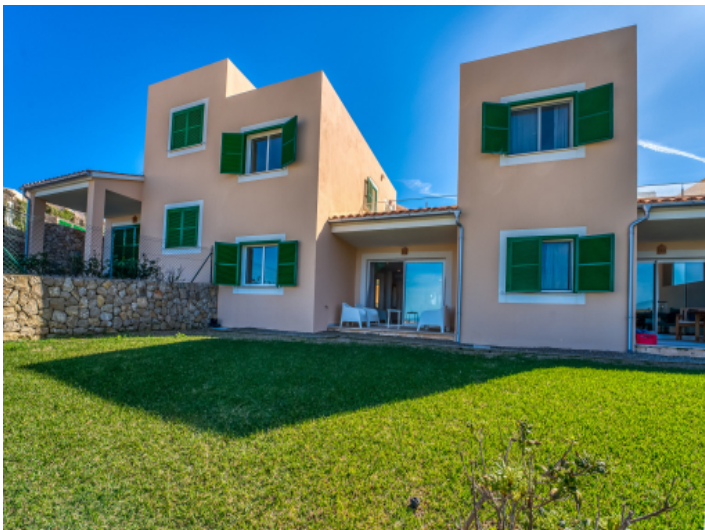
Ansicht auf die Fassade
