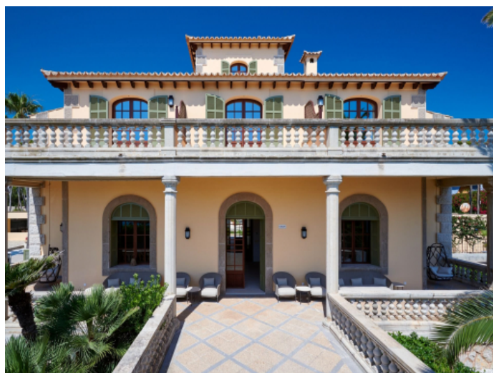
Zugang zur Villa
