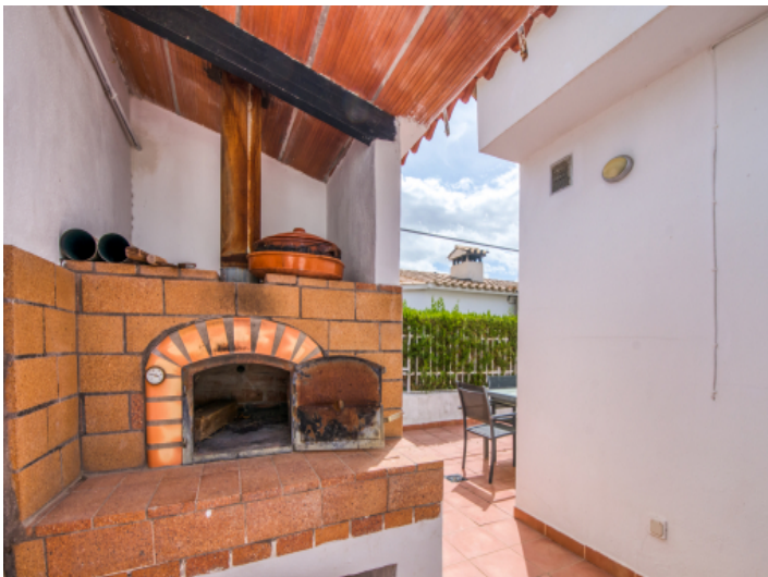
Holzofen auf der Terrasse
