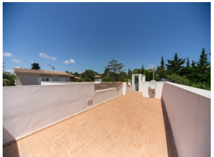
Ansicht der Dachterrasse
