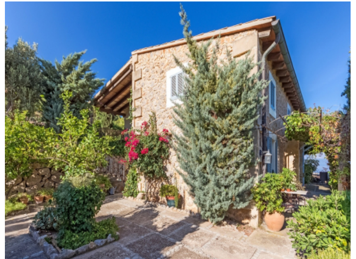
Ansicht der Steinfassade
