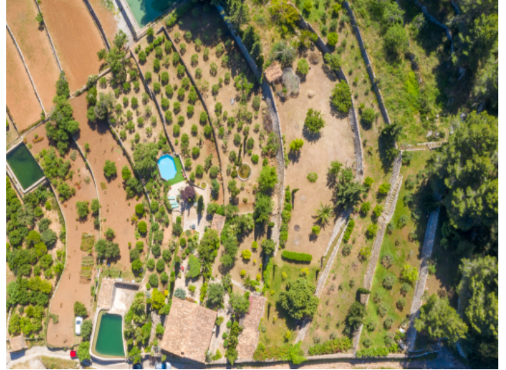
Ansicht des gesamten Anwesens
