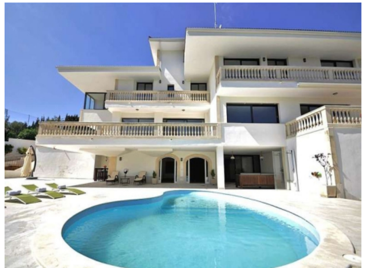
Poolbereich auf der Terrasse
