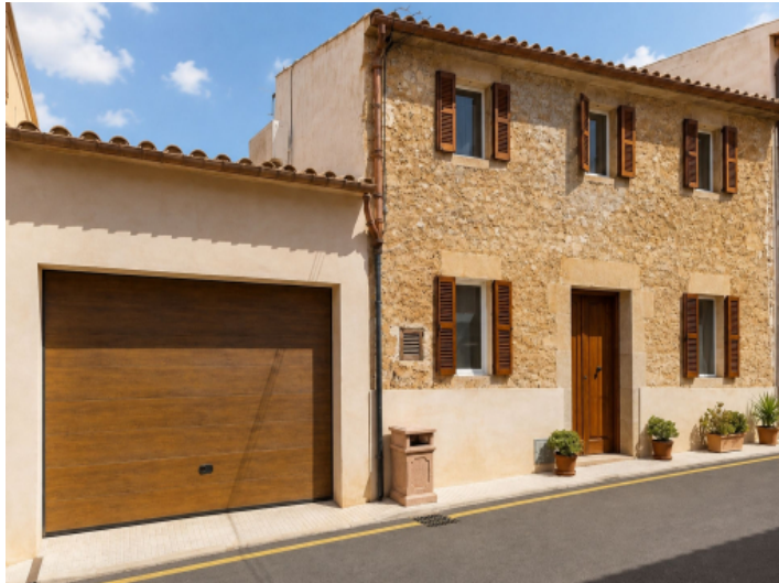
Stadthaus mit Garage
