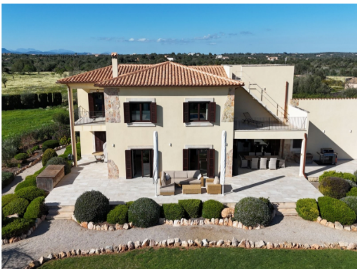
Viele Terrassen und Aussenbereich
