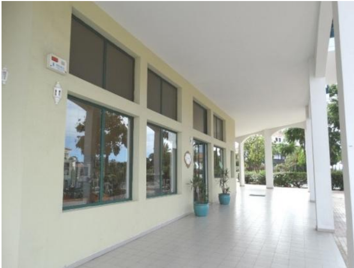
Großzügige Ladenfläche mit ebenso großzügiger Terrasse
