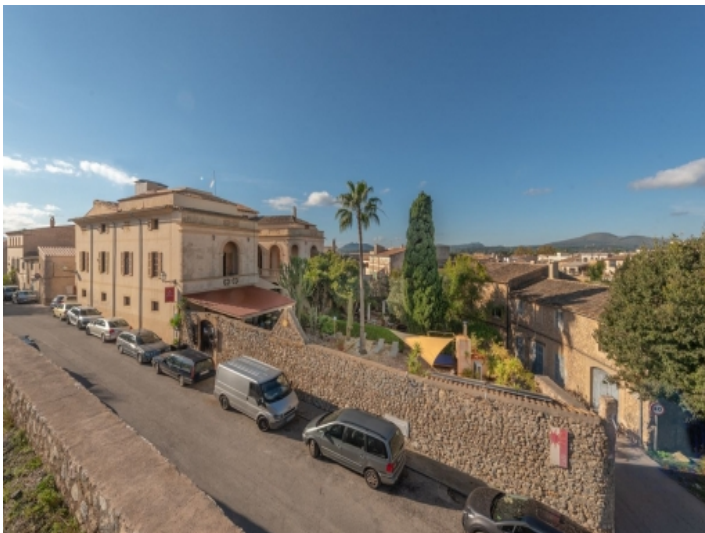
Außenansicht des Hotels
