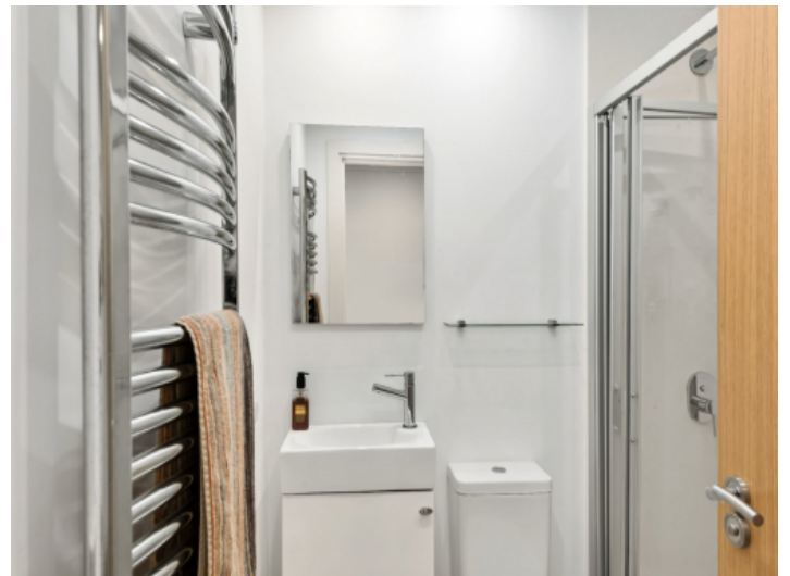
Badezimmer mit Heizung
