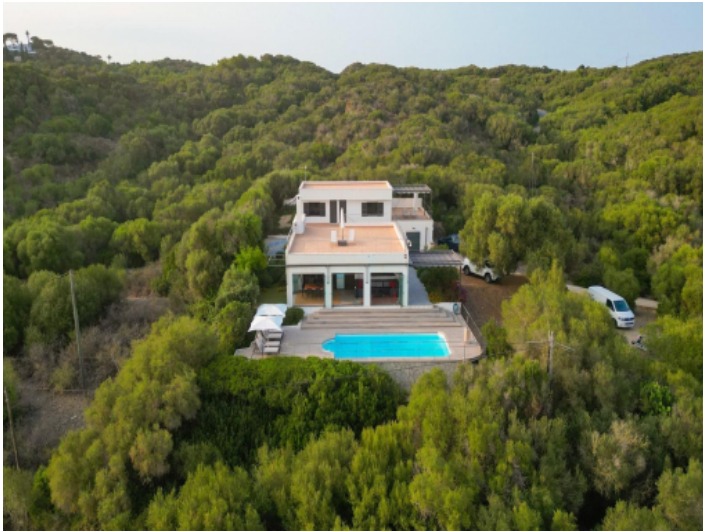
Ansicht auf die Villa
