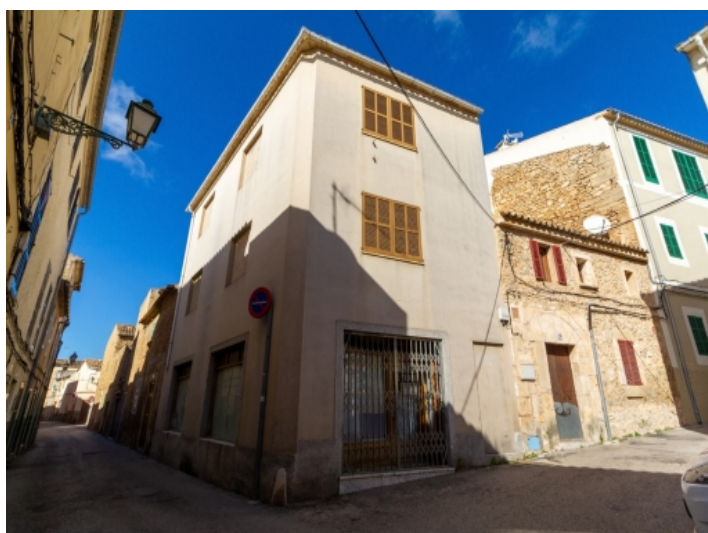
Außenansicht des zweiten Gebäudes
