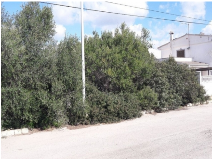
Bebauung von etwa 300 qm genehmigt
